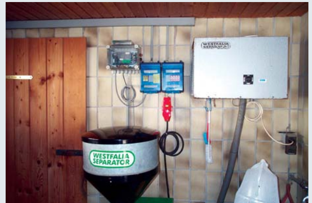
Instalación de ordeño
