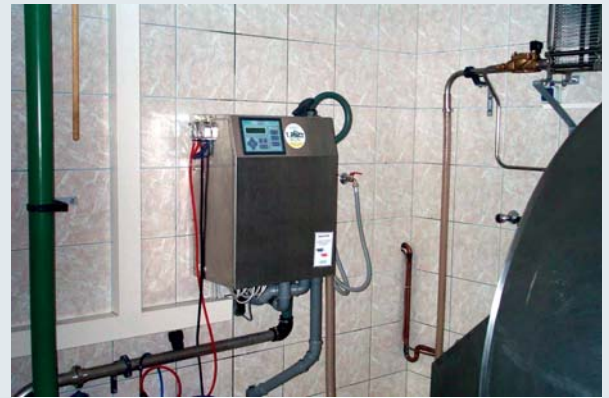
Instalación de ventilación y lavado
