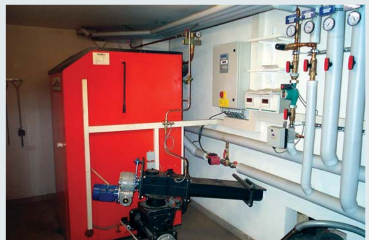
Instalación de calefacción
